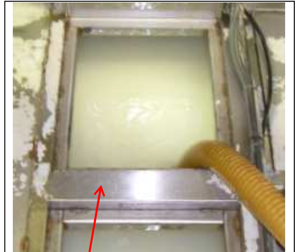
タンク(5ヶ月後の状況)
